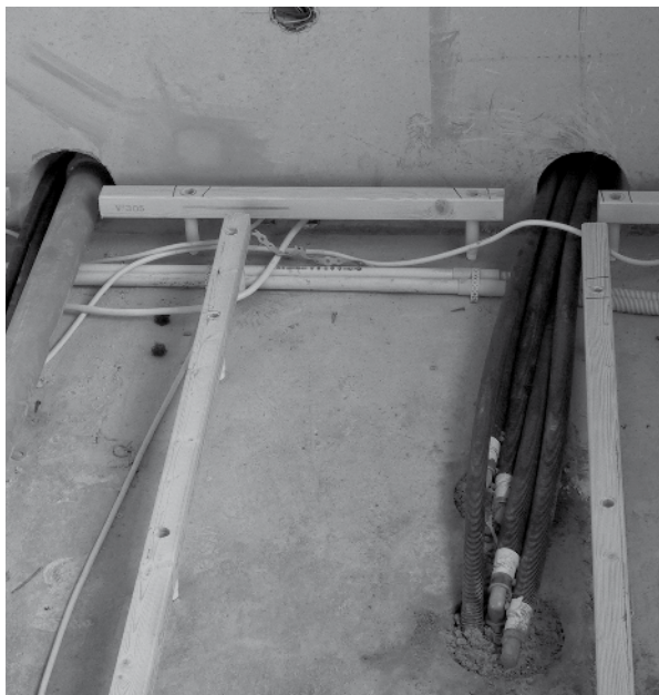
Installationerna är klara, färdigt för att montera Nivell-golvet.
