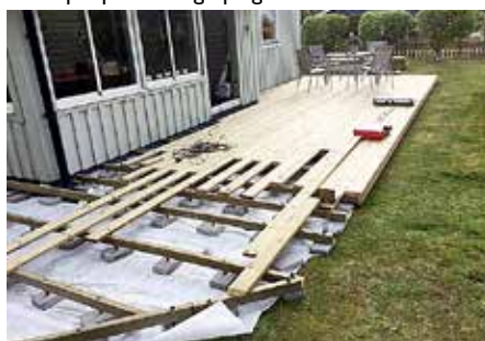
Exempel på montage på gräsmatta med fiberduk
